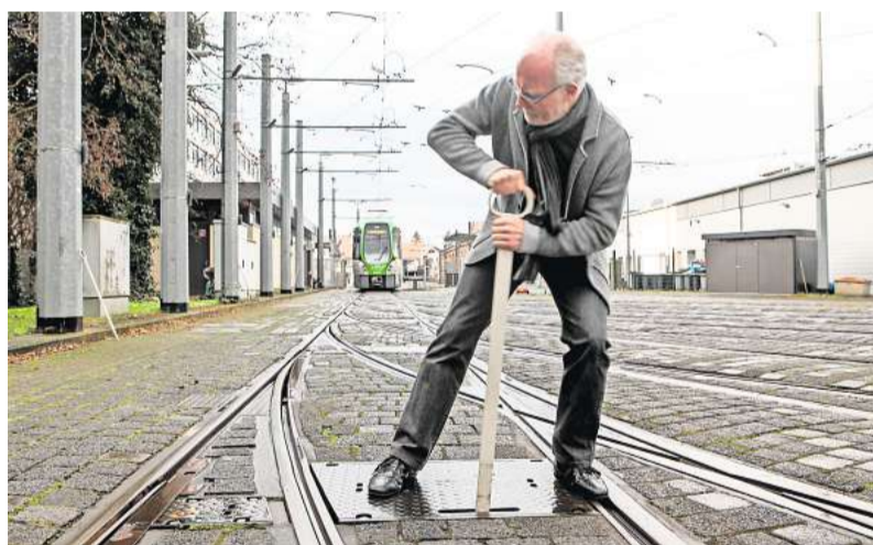
Selbst ist der Redakteur: Bert Strebe lernt, wie er mit dem Weichenstelleisen eine Weiche von Hand umstellen kann.
